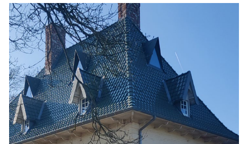
referentie dakkapellen boven: Salens Architecten - residentie Sint-Jan Brugge onder: studiobont - een huis voor Zonnebeke
