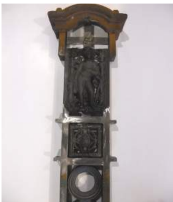
Stijl van smeedijzeren hekwerk gedemonteerd in atelier voor een behandeling. Onderdelen worden opnieuw gelast en nadien vlak geschuurd.
