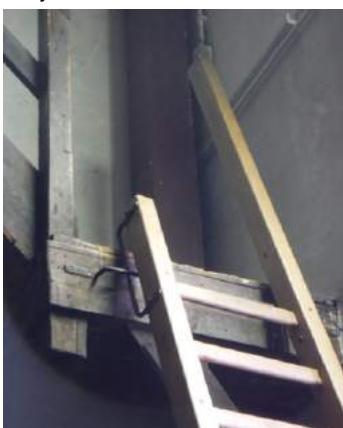
Ladderboom loopt door als handgreep om makkelijker te kunnen
