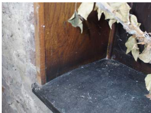
In de aanbouw (zijde kantoorgebouw) zijn er op dagkanten nog een houten bekleding.
