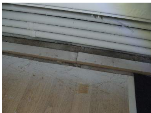
Vloeropbouw in de kamers gelijkvloers: onder het tapijt en het laminaat ligt nog een houten vloer.
