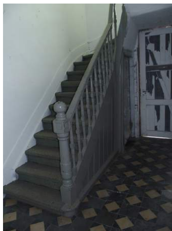
Cementtegels in de hall op het gelijkvloers
