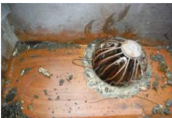
Bladvangers dienen regelmatig proper gemaakt te worden om verstoppingen te voorkomen.
