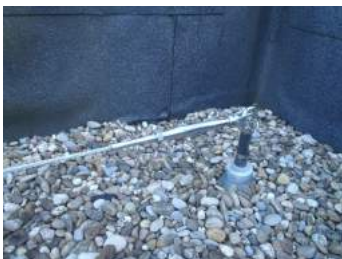
Horizontale ankerlijn
