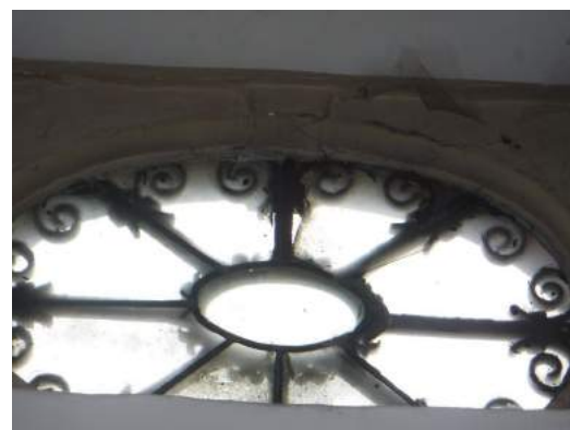
metalen raam met loskomend glas en roest
