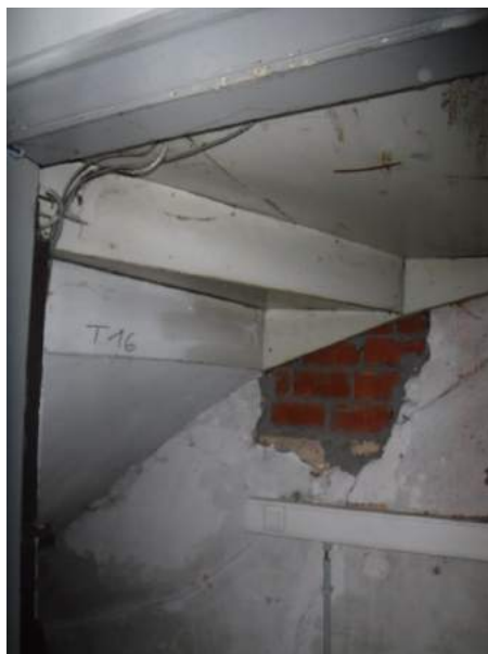
trap met afwerking onderaan
