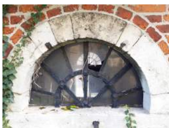
Gietijzeren raamwerkje.
