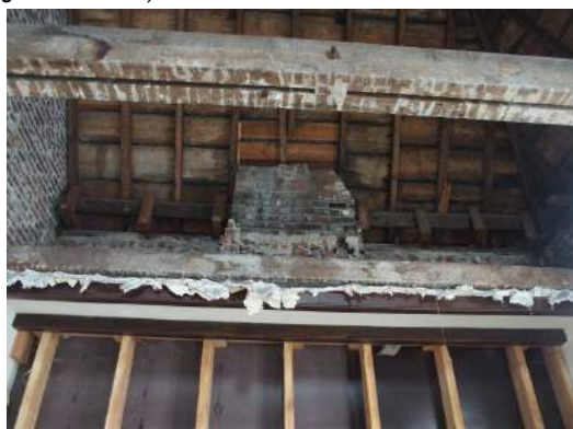
Situatie in de aanbouw (kant gemeentehuis)
