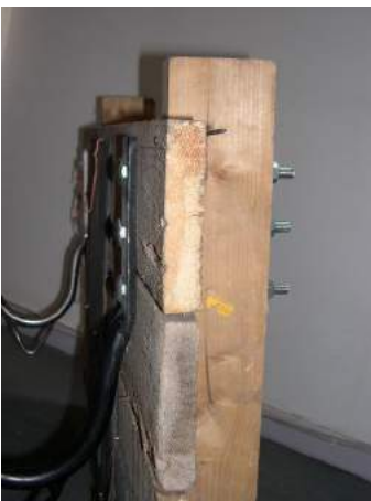
Bevestiging ladderhaken zijn bij voorkeur zichtbaar aan de binnenkant.
