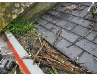
Bladvangers dienen regelmatig proper gemaakt te worden om verstoppingen te voorkomen.
