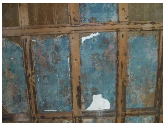
Het behangpapier zit onder het lattenwerk
