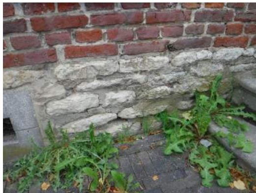
cementgebonden voegwerk
