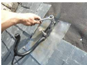
Aanbrengen van een ladderhaak.
