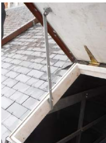
Een voldoende grote opening en een uitzetijzer zorgen voor een gemakkelijkere doorgang.③
