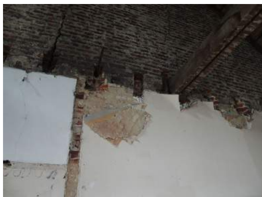
Aftekening van de balken in de muur en van stucwerk op de onderzijde van de moederbalken van het spant.
