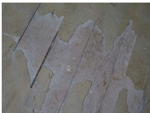
Vloer: helft achterzijde van de aanbouw. Op de planken vloer ligt nog een egalinelaag.
